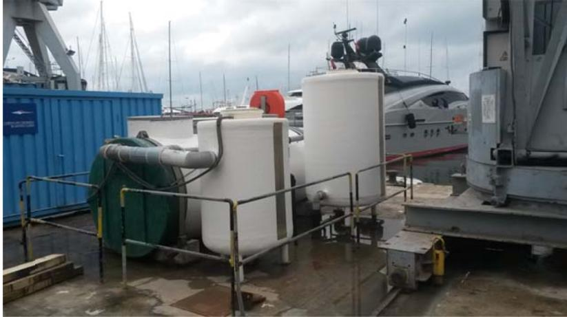
*Ilustración 9.- Planta actual de tratamiento de aguas carenadas en la zona del varadero.*
